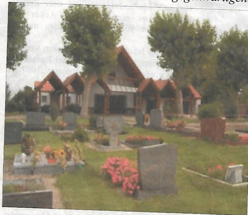
Blick zur gegenwärtigen Friedhofshalle
