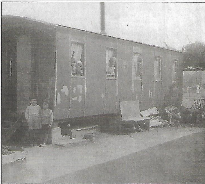
Ausgediente Eisenbahnwaggons zum Eindämmen der Wohnungsnot
