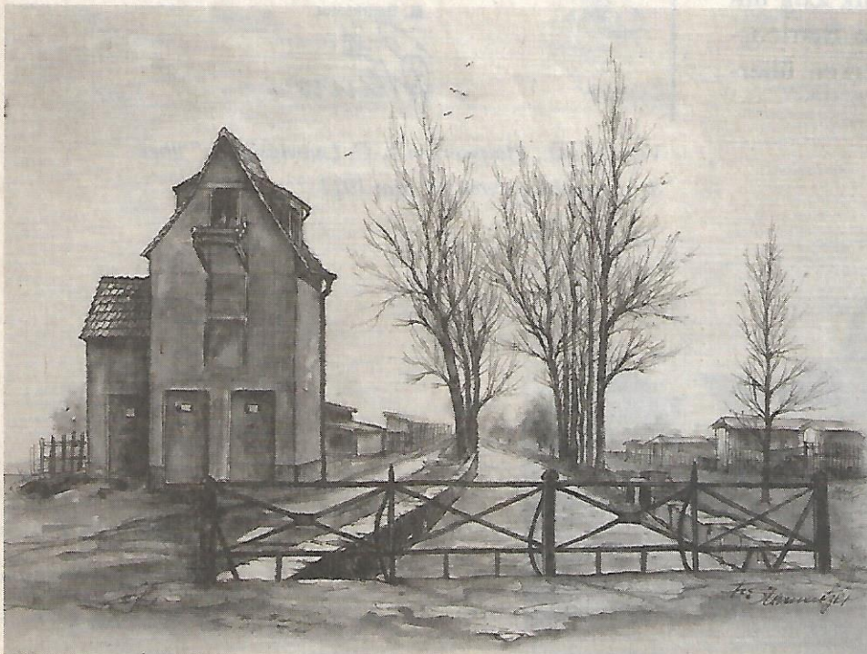
Das Transformatorenhaus, unmittelbar an der Rehbachbrücke gelegen
