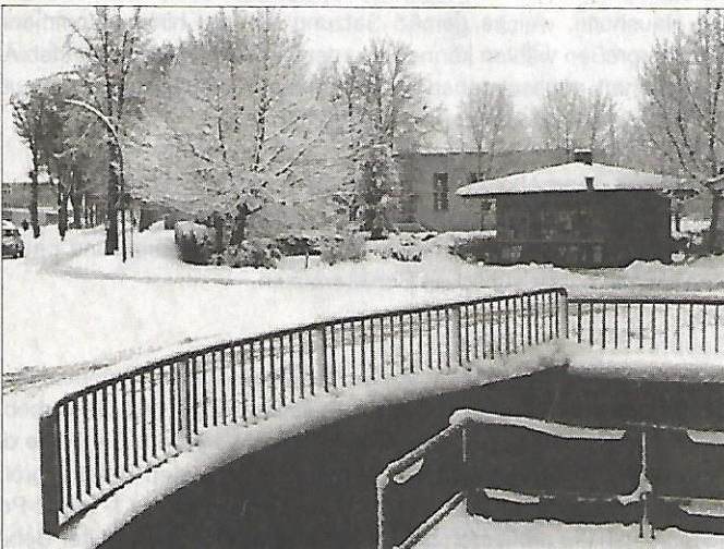
Kiosk "Knopf" im Winter, an der Rehbachbrücke
