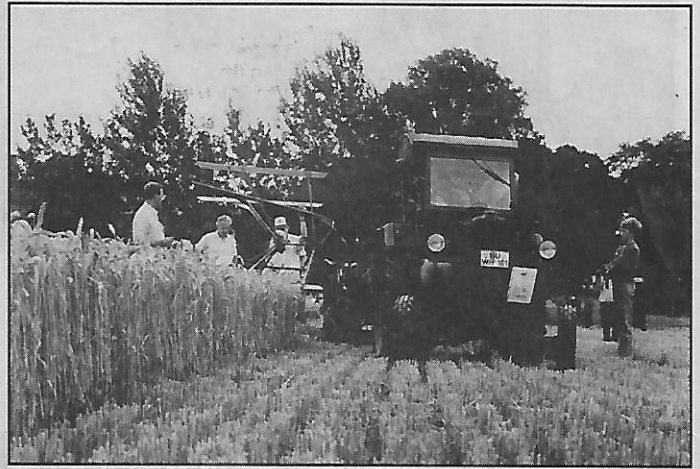
Schneiden und Binden des Getreides mit dem Selbstbinder
