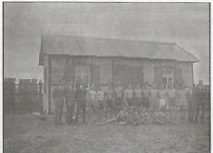
Selbst die Athletenhalle der „Freien Sportvereinigung“, am Rehbachufer gleich nach dem Transformatorenhaus gelegen, wurde für Wohnzwecke umgebaut.
