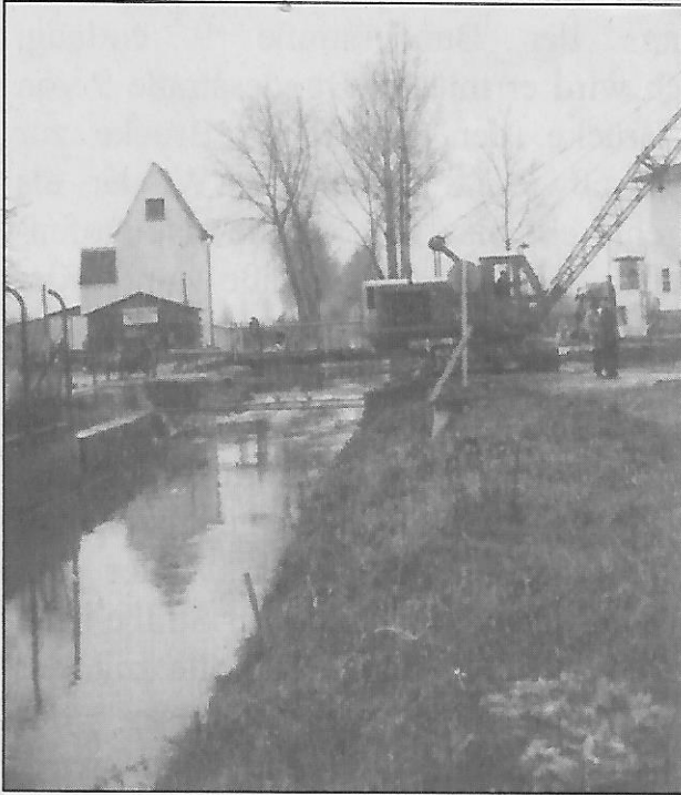
Die Bachbrück an der Jahnstraße wird verbreitert
