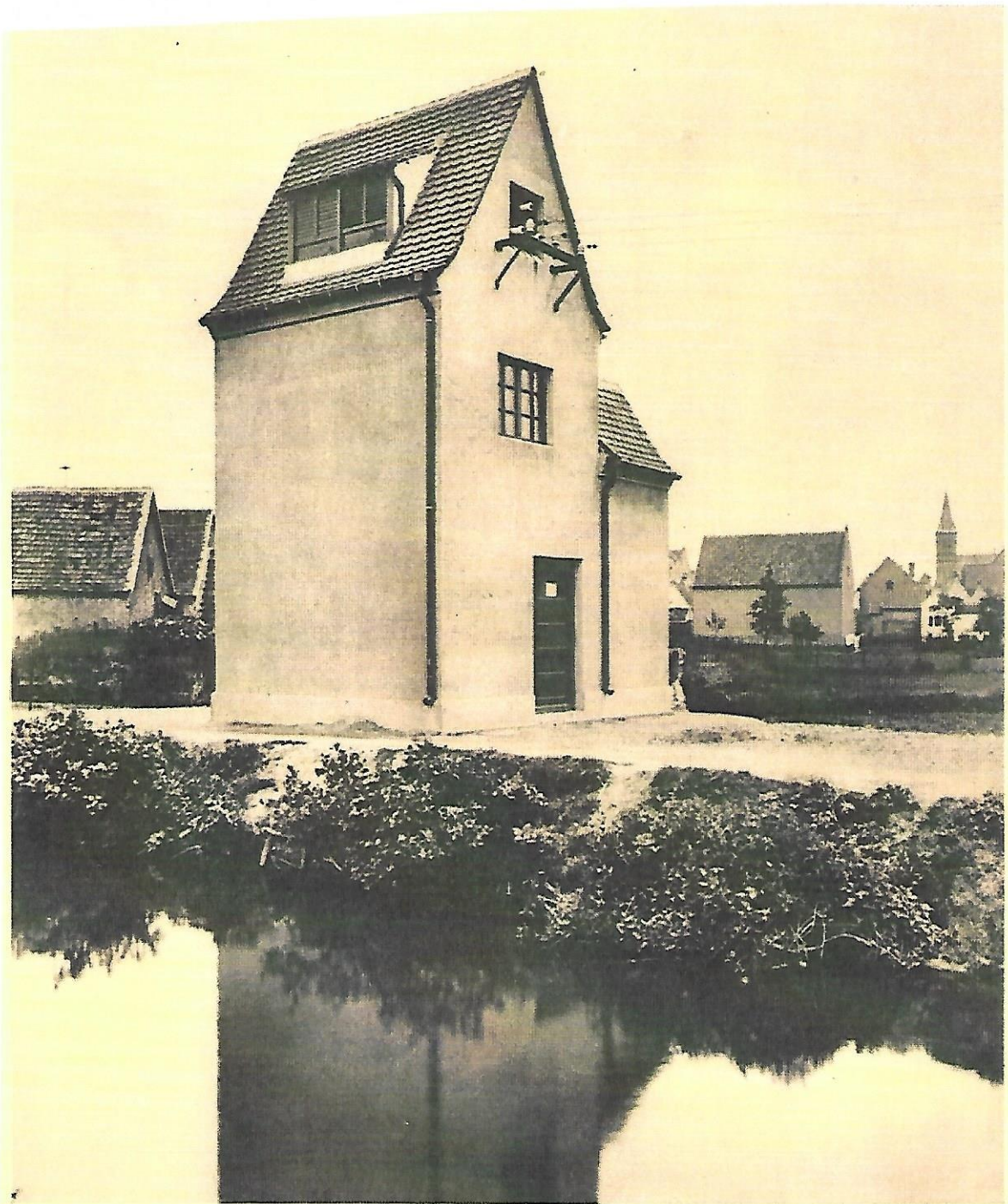
Abb. 28. Transformatorstation Type II und III mit Anbau für Ueberspannungsschutz in Neuhofen
