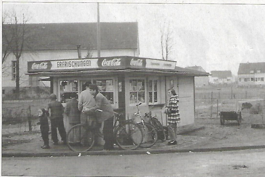
Erstes "Gutzelhäuschen" der Familie Knopf, unmittelbar an der Bachbrücke gelegen
