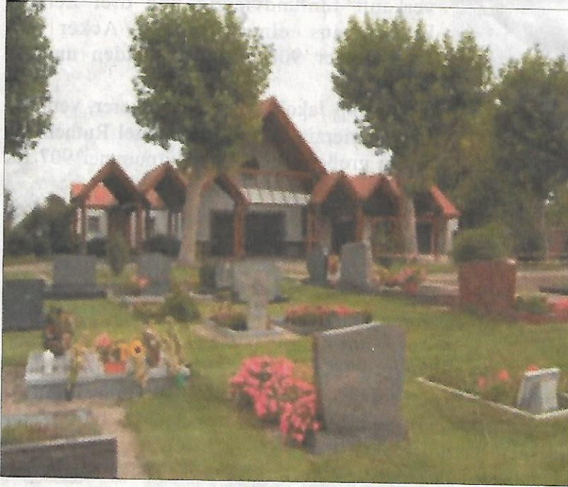
Blick zur gegenwärtigen Friedhofshalle
