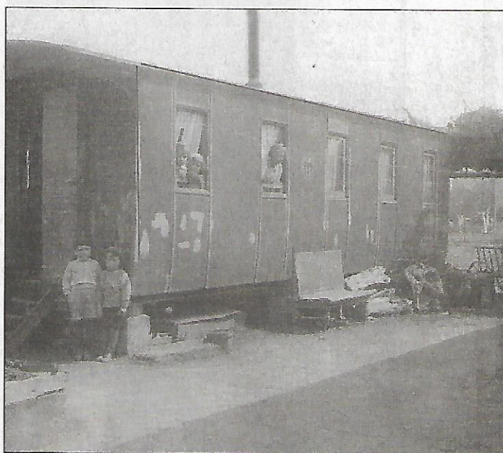
Ausgediente Eisenbahnwaggons zum Eindämmen der Wohnungsnot
