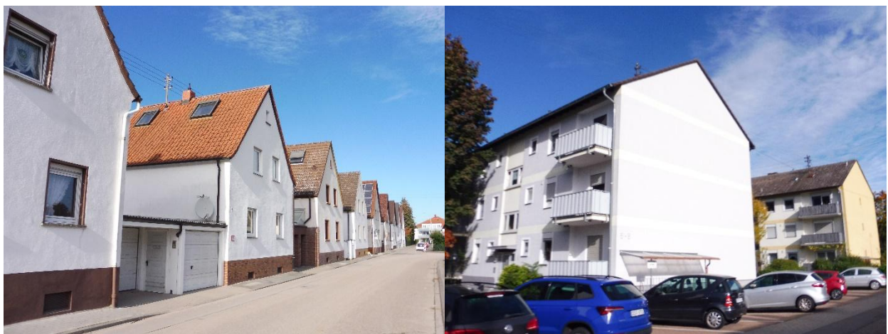
Abbildung 5: Blick in die Straße „Auf der Hasenplatte“ (li.), Mehrfamilienhäuser in der Eschkopfstraße (re.) (Quelle: Fotodokumentation)
