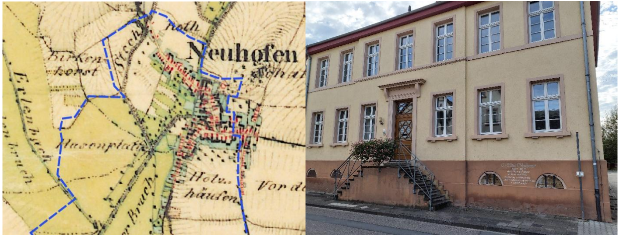
Abbildung 4: Grundriss um 1840 (li.), denkmalgeschütztes altes Schulhaus (Ludwigshafener Straße) (Quelle: Landesamt für Vermessung und Geobasisinformationen 3 , Fotodokumentation, UG blau markiert)
