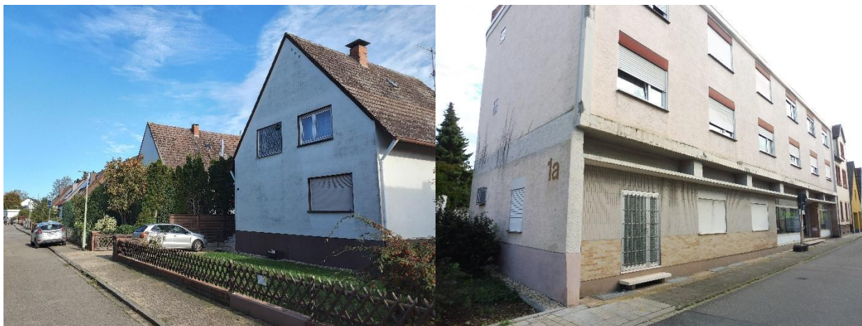
Abbildung 9: Un-/teilsanierter Gebäudebestand, Altersklasse ab 1950 (li.) und 1970/80er Jahre (re.) (Quelle: Fotodokumentation)
