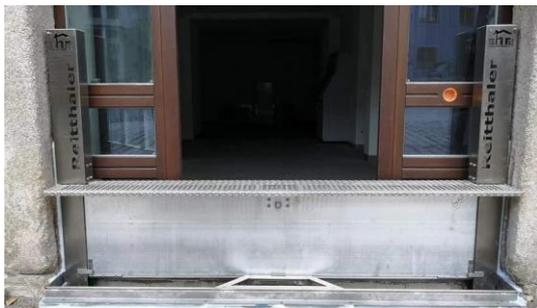
Vertikalschott – Schutzklappe horizontal nach oben ausfahrend
