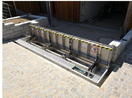
Klappschott – Schutzklappe um 90° aufrichtend
